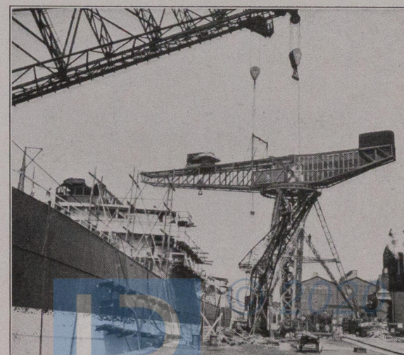
Die 150-t-Kräne vollziehen den Einbau der Maschinenanlagen und den Aufbau des Oberdecks.
