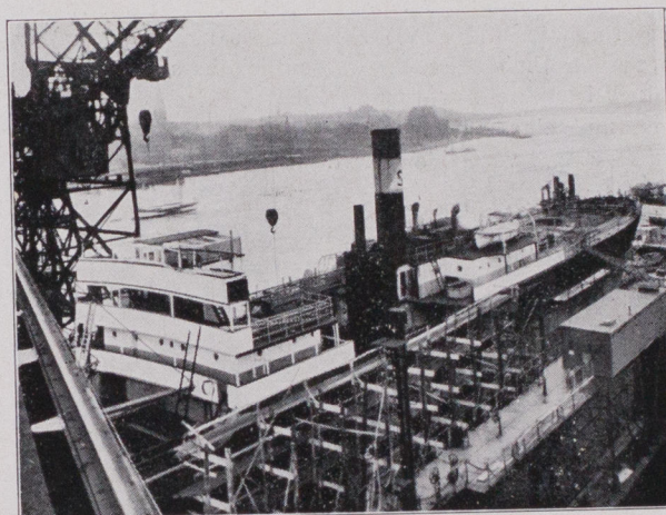
Die „Duburg“ im Schwimmdock der Germaniawerft. Es erfolgt hier der Einbau eines Zwischenstückes von 12,6 m Länge
